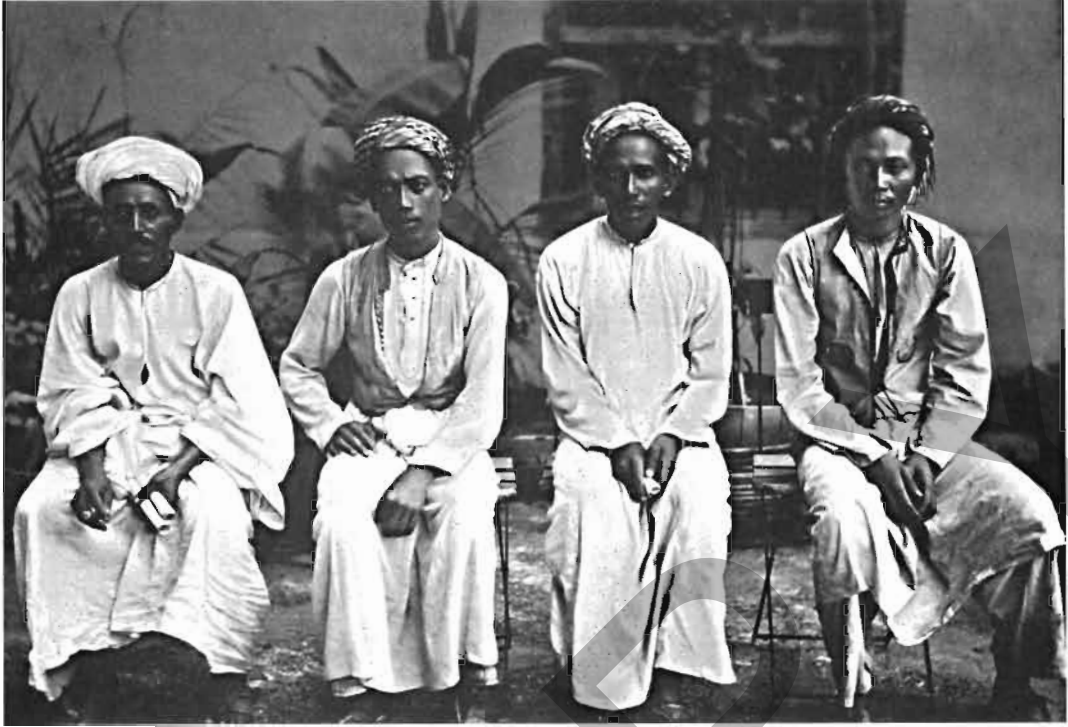
(٧١): صورة نشرها سنوك في الألبوم الأول رقم ٢٧، حجاج من يونتيانك (غرب بورنيو) وفي أقصى اليسار حضرمي من جزيرة العرب يقطن هناك
